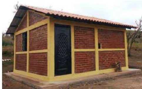
Figura 1. Mampostería confinada. Fuente: Belli, (2016)
