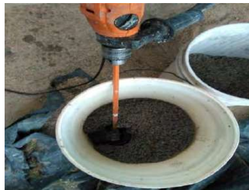
Figura 23. Mezcla batida taladro y batidora de pintura
