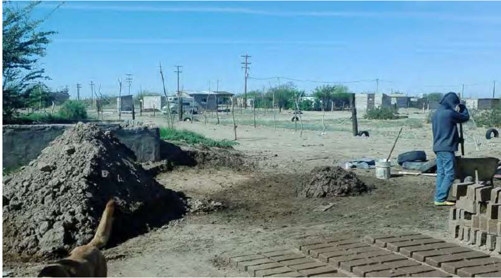
Figura 9. Amasado la mezcla para la elaboración de ladrillos
