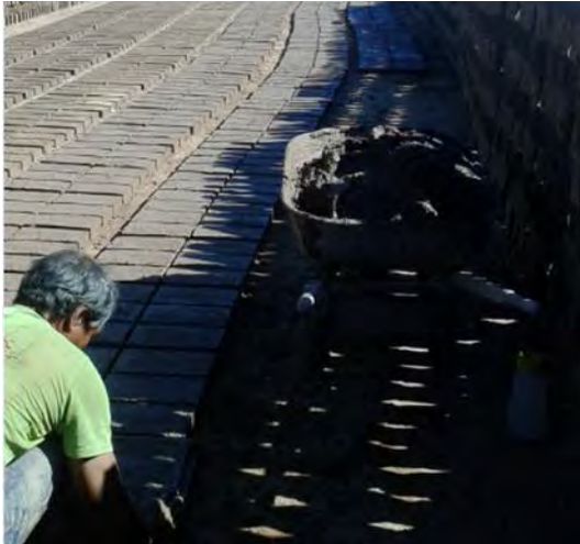
Figura 12. Moldeo manual del ladrillo por medio de rejilla de madera
