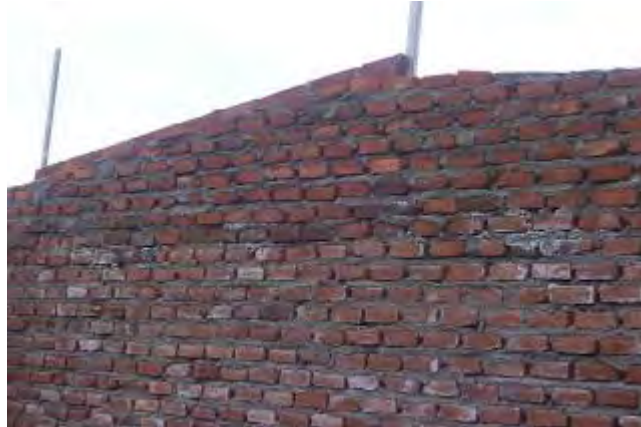
Figura 2. Mampostería simple. Fuente: Todo sobre arquitectura, (2018)
