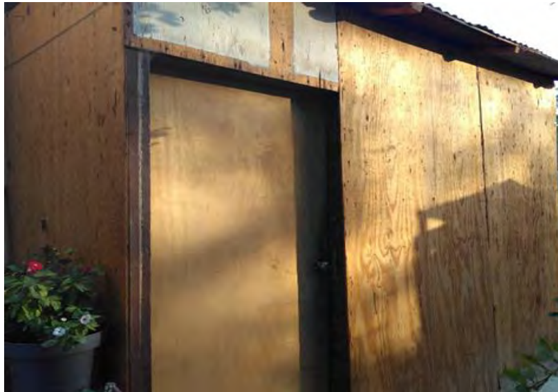
Figura 25. Cámara de fraguado de madera
