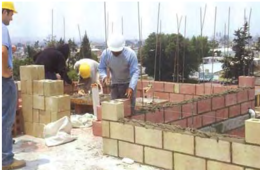
Figura 18. Construcción con bloques de concreto. Fuente: González, (2018)
