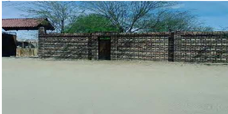
Figura 4. Barda realizada con ladrillo cocido en San Luis Río Colorado
