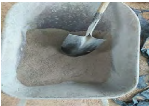
Figura 22. Mezcla batida con la pala
